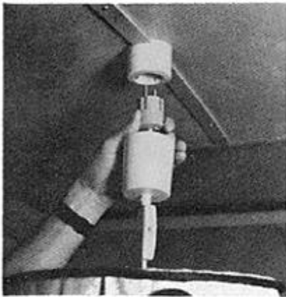
Bild 9 Anbau der Pendelleuchte
